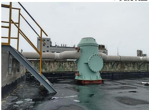
实验室废气处理装置
